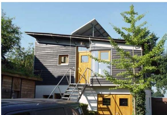
Abb.3 Ein schlichter Holzbau mit Holzfassade. In knapp 15 Jahren dreimal an- und umgebaut bzw. technisch nachgerüstet. Ein Holzbau bietet hierfür die besten Voraussetzungen
