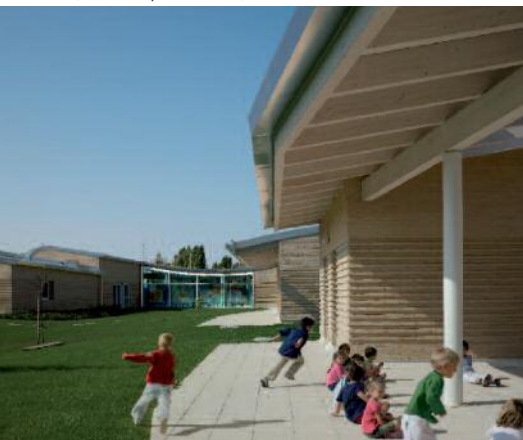
Ravenna, nouveau pôle scolaire, 2003 / 2008
