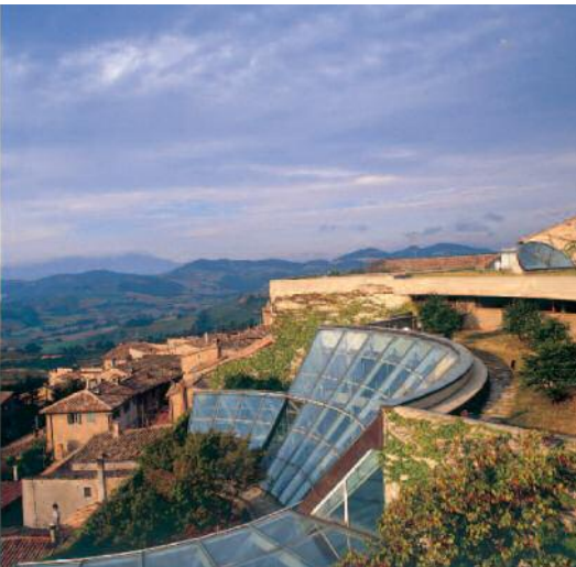
Urbino. Faculté de Lettres, aperçu de la lucarne qui éclaire les grandes salles de classe, 1968-1976
