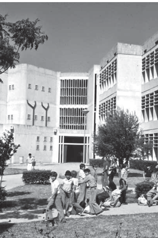
Institut technologique ALTAIR - Seville premier prix d'Architecture et Médaille d'or de l'Université de Séville
